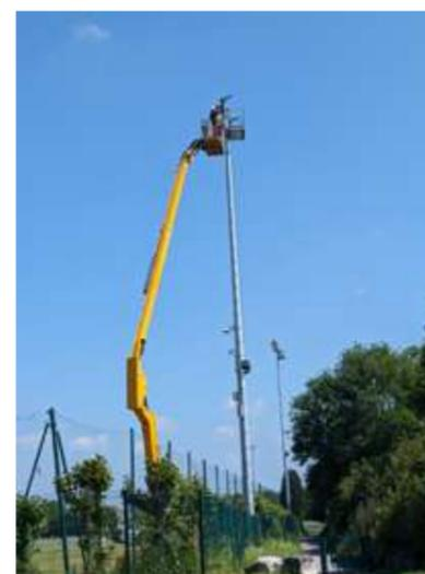
Les travaux, menés par CITEOS, consistent à remplacer le parc de luminaires par des éclairages LED plus performants.
