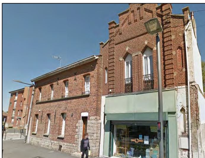
Maison ancienne avec soubassement en grès et maison à façade redans rue Barbusse
