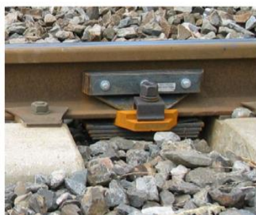
Absorbeur de vibrations sur rail (source SNCF)
